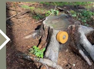
Anbringung: **an einem Baum:** - mit 180er Schraube+M24
