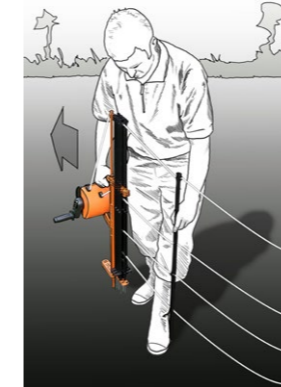
STAP 4 STAP 4a Plaats de palen naar eigen inzicht. Wanneer een hoek gemaakt moet worden, gebruik dan een scheerlijn zodat de hoekpaal recht blijft (4a)
